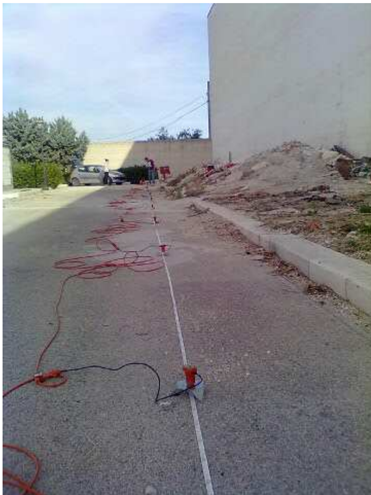
Indagine sismica a rifrazione
