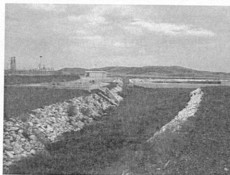
A monte mediante la realizzazione di un piccolo laghetto con scarpate a lieve pendenza rivestite in scogliera di pietrame calcareo. A valle tramite opera di raccordo all'alveo del torrente Rio Salso. A monte come a a valle le scarpate della sistemazione sono state previste rivestite in scogliera di pietrame calcareo.
