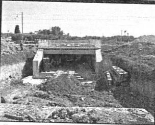
Manufatto di attraversamento realizzato in opera posto al di sotto della rete ferroviaria con sistemi oleodinamici e sistemi Essen per la continuità del traffico ferroviario
