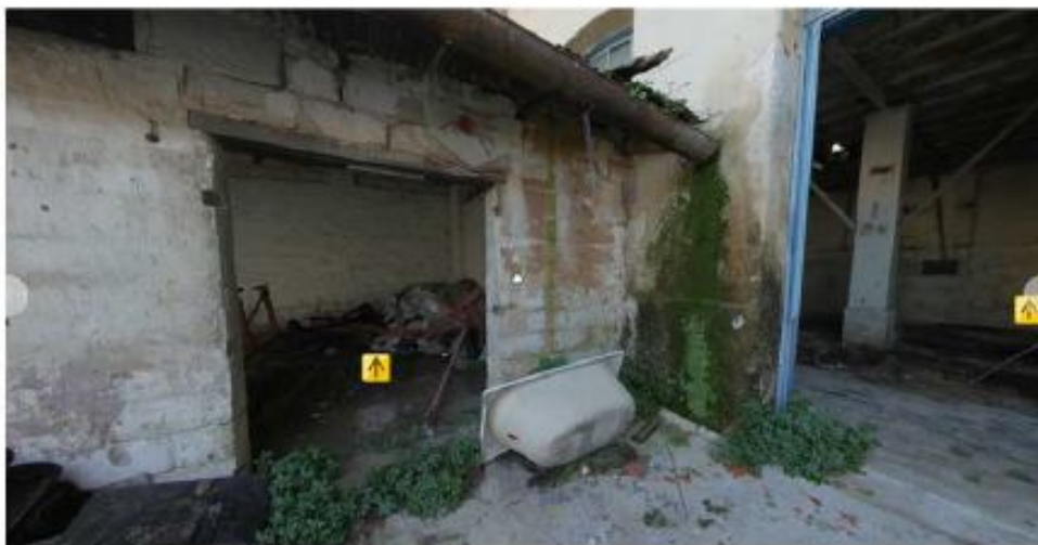
10-11-12. Viste interne corpi di fabbrica (fonte relazione Samarelli)
