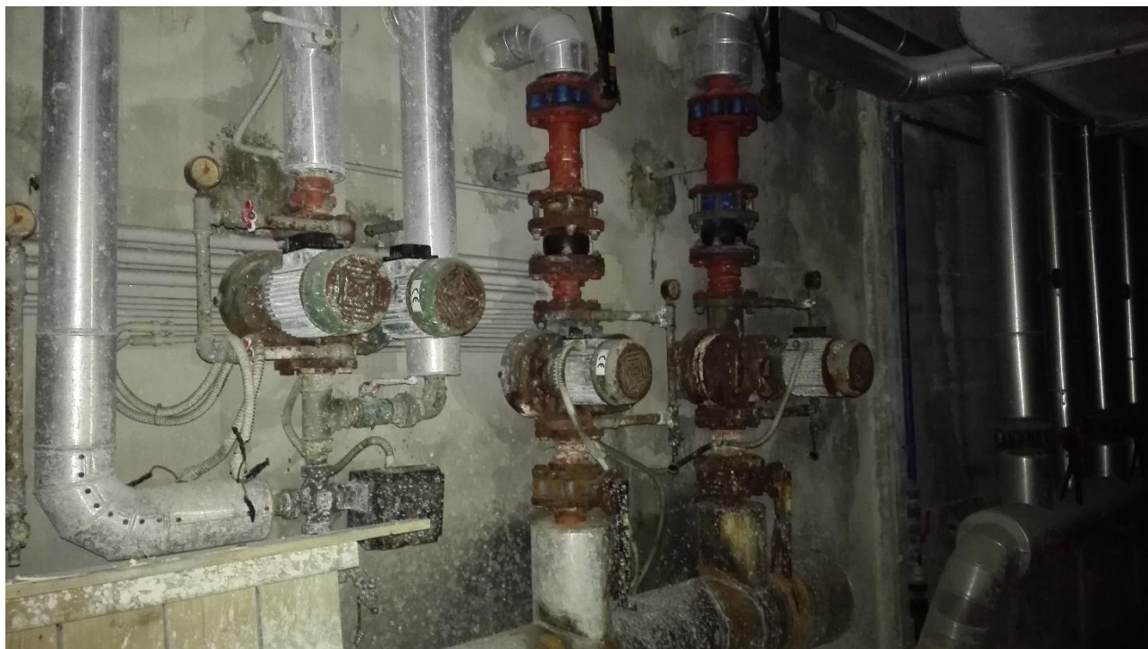
Foto 21_ locale pompe (circuiti secondari)
