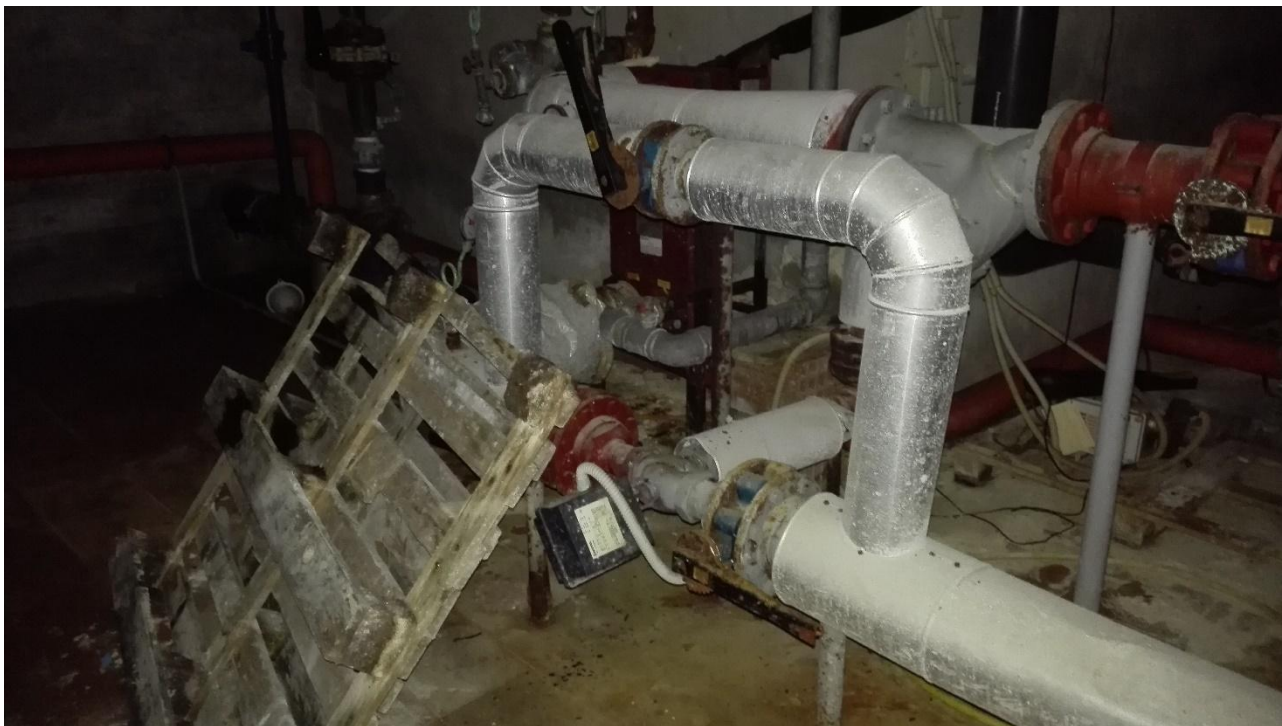
Foto 15_centrale idrica (scambiatore riscaldamento vasca 25 m)
