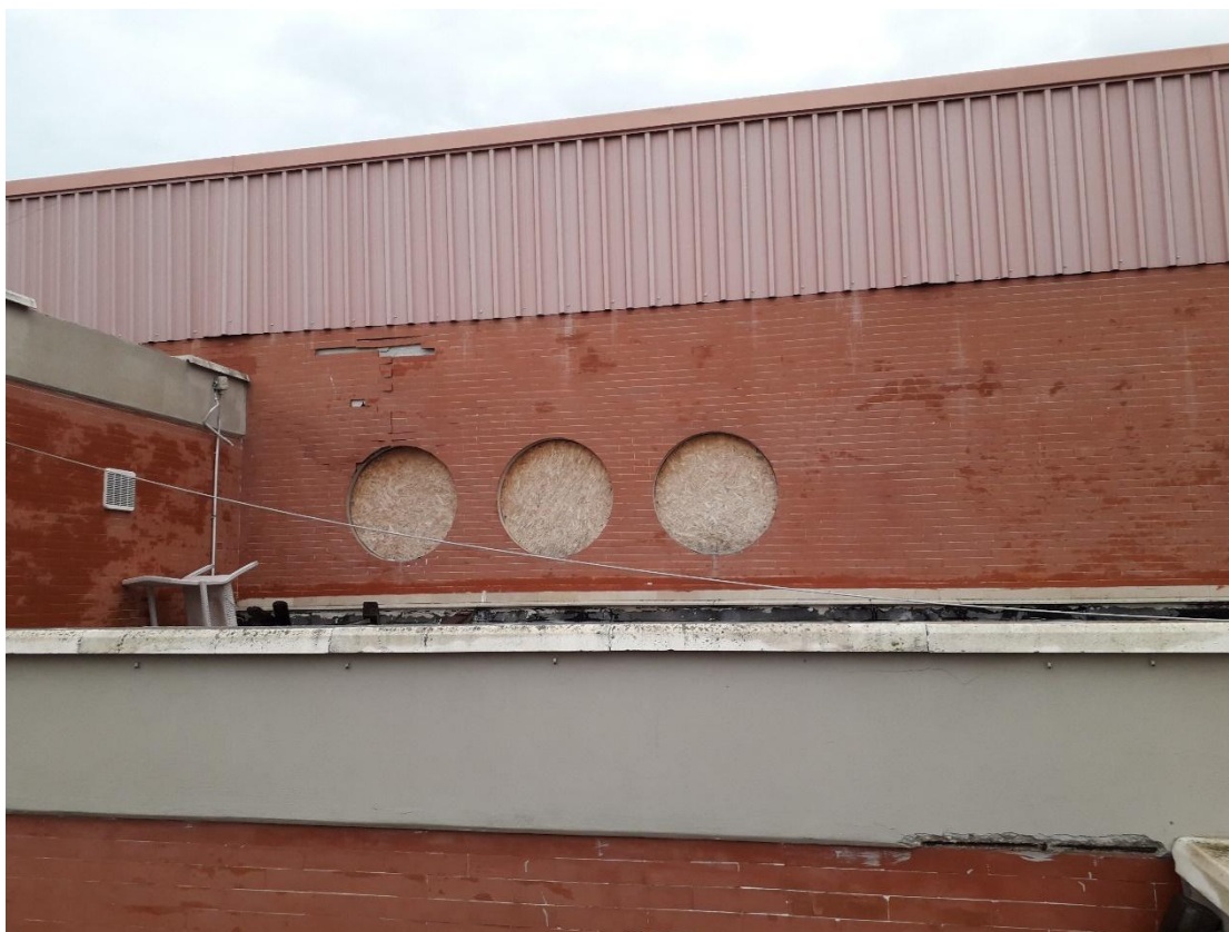
Foto 1 _rivestimento in mattoni di cotto ammalorato
