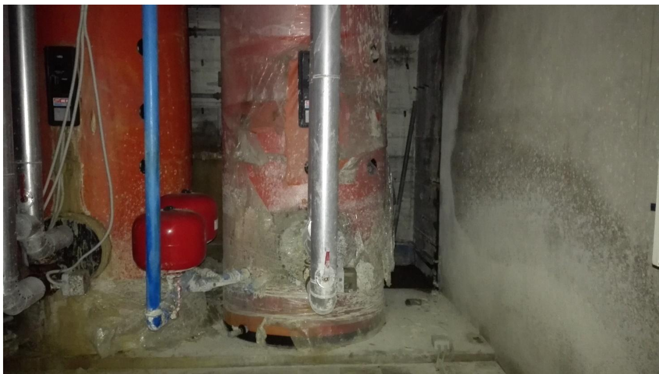
Foto 14_centrale idrica (bollitori acs)
