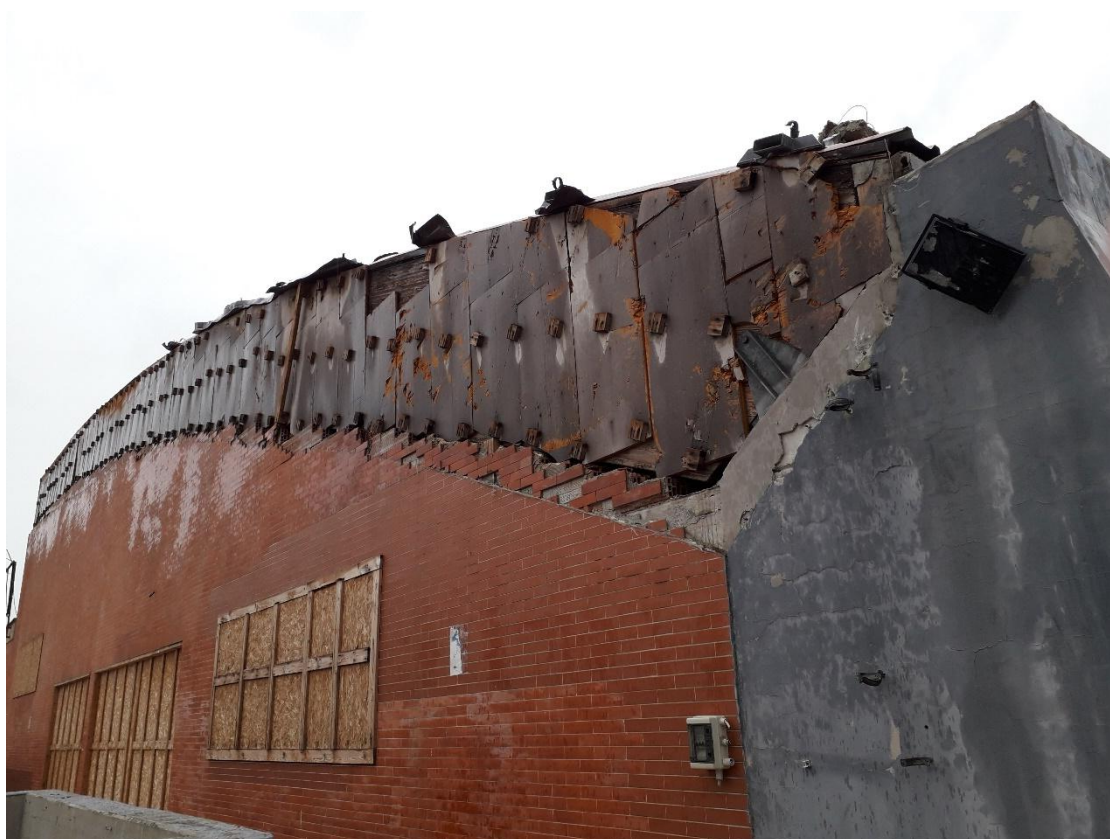
Foto 2 _fascione di protezione travi lignee e rivestimento esterno in mattoni
