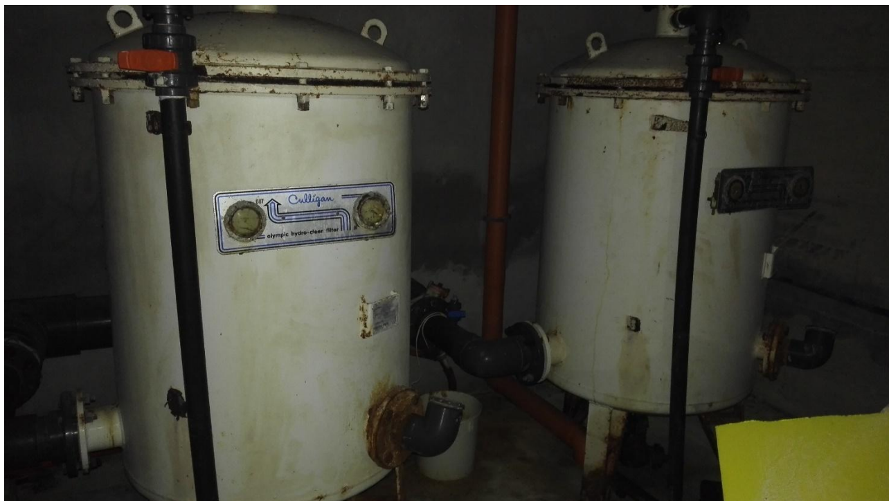
Foto 19_ centrale idrica (filtri vasca 25 m)
