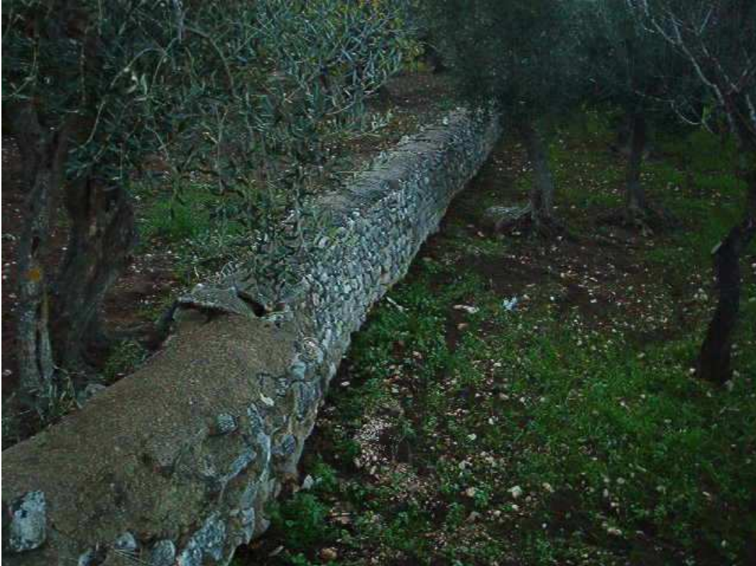
Foto 1: ciglio di scarpata, identificato nell’elaborato di cui al PUTT/Puglia. In realtà trattasi di un muretto a secco, interpoderale (solo parzialmente cementato nella parte superiore), realizzato per contenere il terreno agrario
